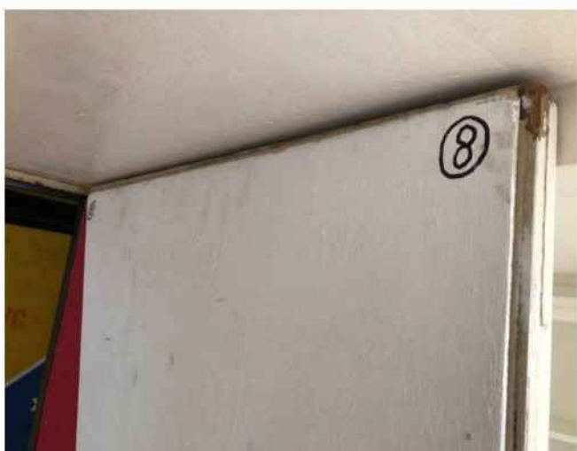
brandwerende plaat op deur ( Promat masterboard)
